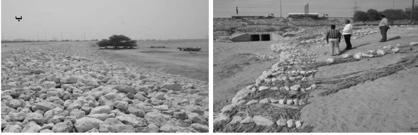
الشكل (١) - استخدام المواد الصديقة للبيئة والسدود المدعمة بالجيوتكستايل للتحكم بالسيول في منطقة الشعبة
