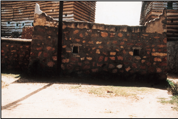
الشكل رقم (١٤): يشكل المسجد في القرية بجنوب غرب المملكة نواة القرية، والصورة توضح مسجد الحي في القرية حيث يتم بناؤه بالحجر رغم أن المساكن تكون مبنية من مداميك الطين وأحجار الرقف.
