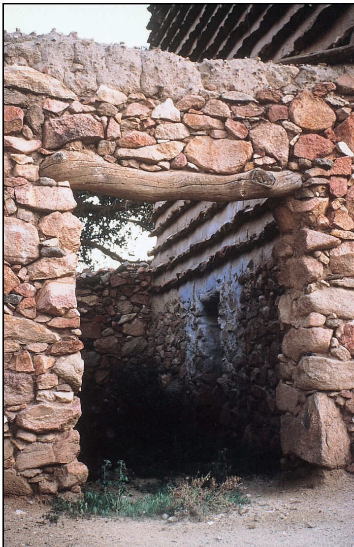
الشكل رقم (٢١): مدخل الحوش الخلفي لأحد البيوت في قرية آل الخلف يوضح نظام التشييد للأسوار وهو عبارة عن حجر وردي دون مونة لاصقة.
