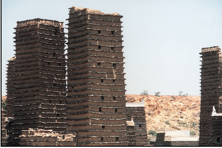
الشكل رقم (٨): تتميز مباني جنوب منطقة السراة بمعالجات مناخية للمباني وذلك بحماية الجدران بالرقف الذي هو عبارة عن رقائق حجرية بين مداميك الطين.
