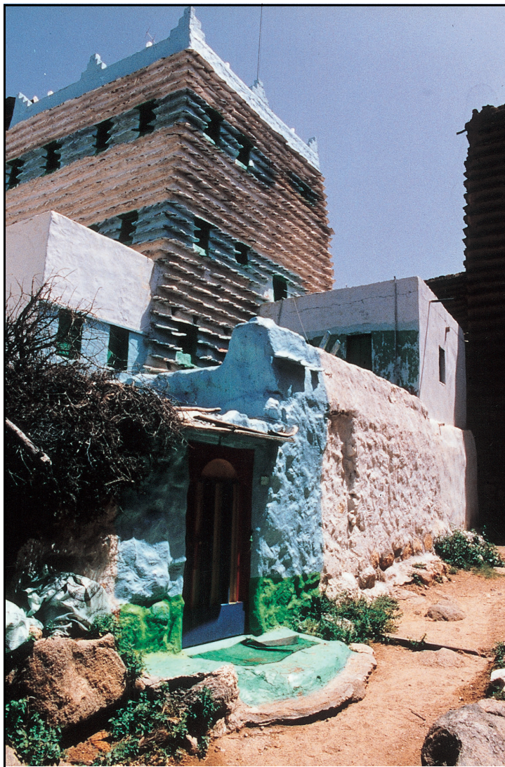
الشكل رقم (١١): تستخدم الألوان الطبيعية لمواد البناء أو الزخرفة في تجميل مباني القرية الخاصة وإعطاء صورة مميزة لها.
