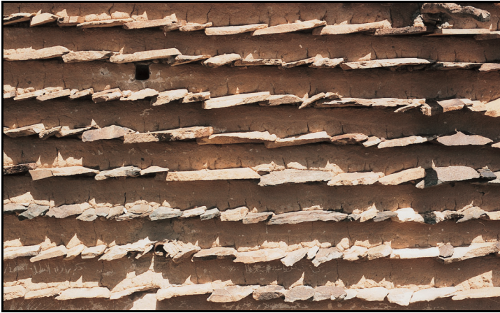
الشكل رقم (٩): تفصيل للرقف بين المداميك.
