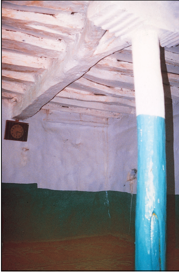
الشكل رقم (١٠): يستخدم المرزح أو السطاع (العمود الخشبي الدائري) والمعادل (الجسور الخشبية) والسواري الخشبية المتعامدة عليها في حمل الأسقف للفراغات المفتوحة مثل المساجد أو المجالس الكبيرة أو المخازن.
