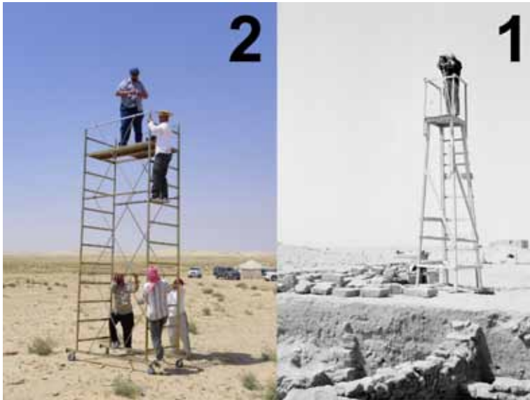
لوحة ١٢: صور توضح الاستخدام الأول للسقالة الخشبية في موقع القلعة الهلنستية من قبل البعثة الدنماركية في ستينات القرن الماضي، وقد تم تصنيعها يدوياً في الموقع، الصورة ٢ سقالة من الحديد جاهزة ويتم تركيبها في الموقع استخدمت في تصوير أحد المدافن في منطقة الصبية في مارس سنة ٢٠١٠، المصدر: إدارة الآثار والمتاحف - مراقبة الآثار.
