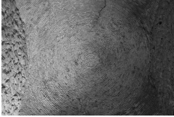
شكل (٥) مالقة. القصبه. القبة الضحلة التي تغطي البوابة الرئيسية
