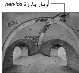
شكل (١٨). روما. الفيلا المسماة بسيّتي باسّي Sette Bassi. قبو ذو أوتار بارزة متقاطعة (عن: Rivoira, Lombardic)
